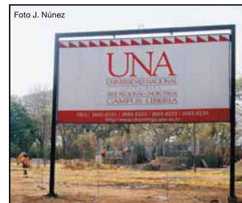
Nuevo campus Liberia incorpora módulos que conviven con áreas verdes que permiten la iluminación natural y la ventilación cruzada.
